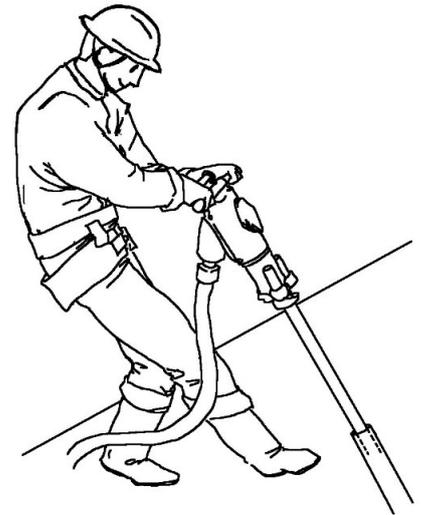
アンカー角度は法面に対して約 90° で削孔を行う。
